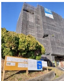
生活訓練事業所あい 大規模修繕の様子
